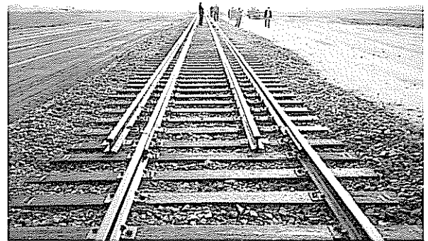
4線軌道の敷設箇所
