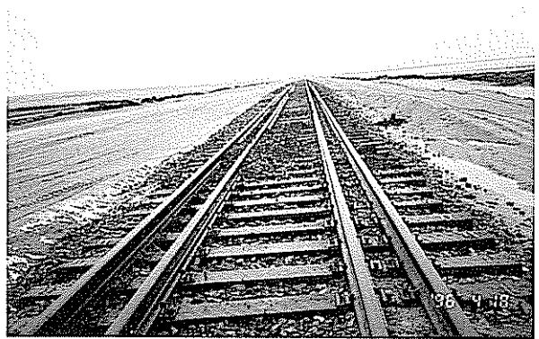
← 中国軌道 (1435mm) → ← ロシア軌道 (1520mm) → 4本レール敷設現場
