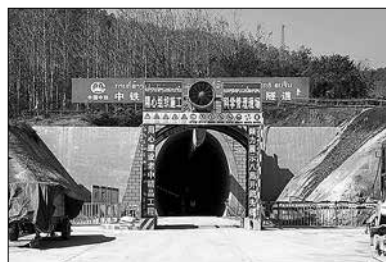
写真25 ルアンプラバン駅北側のトンネル
