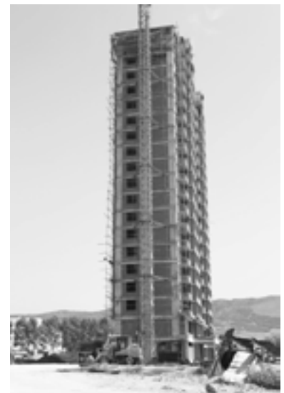
写真4 建設中の高層アパート
